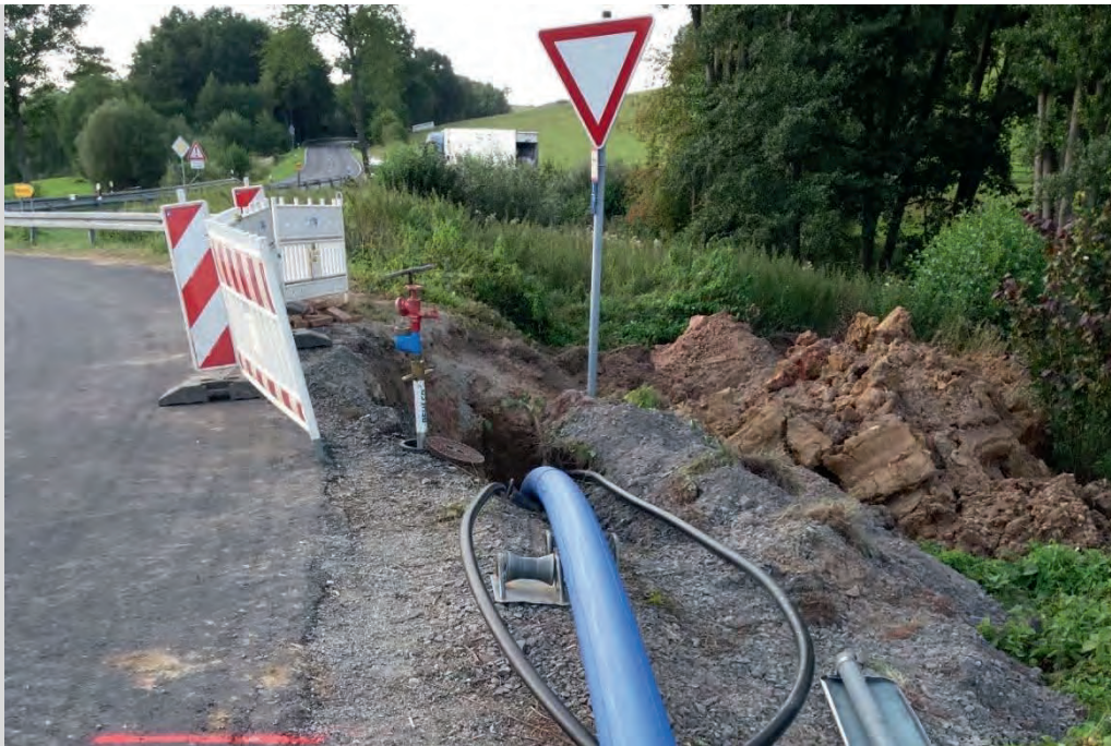
Ansicht 92: Erneuerung der Wasserleitung in Hosenfeld (Quelle: Gemeinde Hosenfeld)
