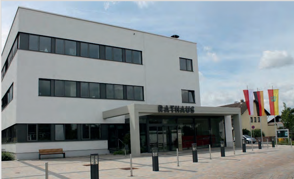
Ansicht 78: Rathaus in Rodenbach (Quelle: Gemeinde Rodenbach)
