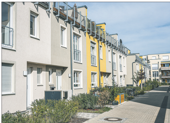
Mit seriellem Bauen lassen sich Skaleneffekte erzielen, die die Schaffung von bezahlbarem Wohnraum ermöglichen, meinen die Autoren einer neuen Studie.
